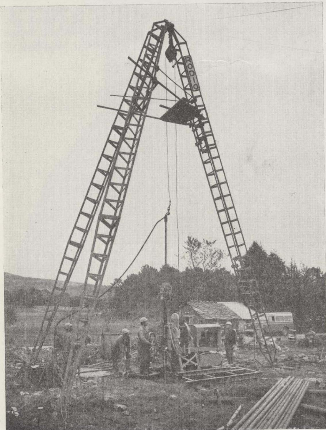
Equipo de sondeo perforando a 400 m. con recuperación continua de testigo desde la superficie y colocación posterior de piezómetros.
